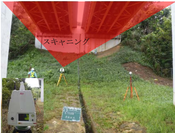
写真-1 測量状況
