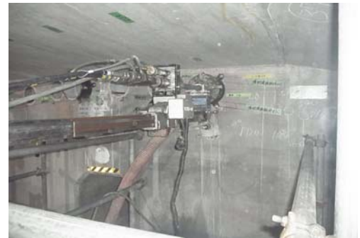
写真-2 外ケーブル偏向部削孔状況
