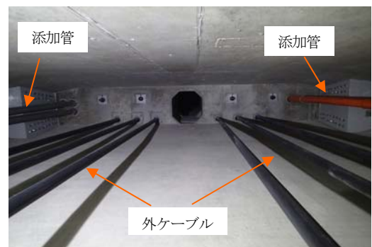
写真-6 完成写真(桁内)
