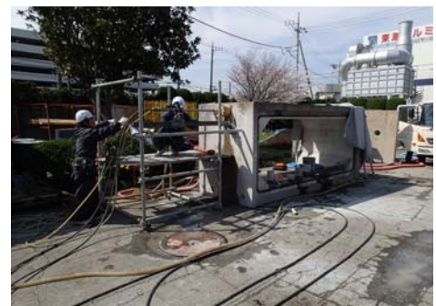
写真-1 長尺WJ施工性確認試験
