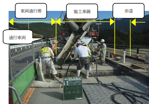
写真-4 ヒンジ部の半断面施工
