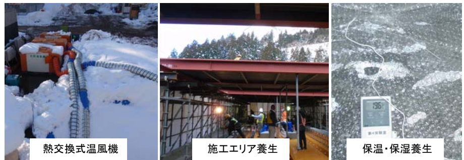
写真-4 養生状況
