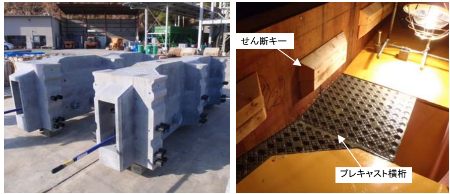
写真-1 プレキャスト横桁
