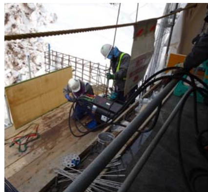
写真-5 外ケーブル緊張状況
