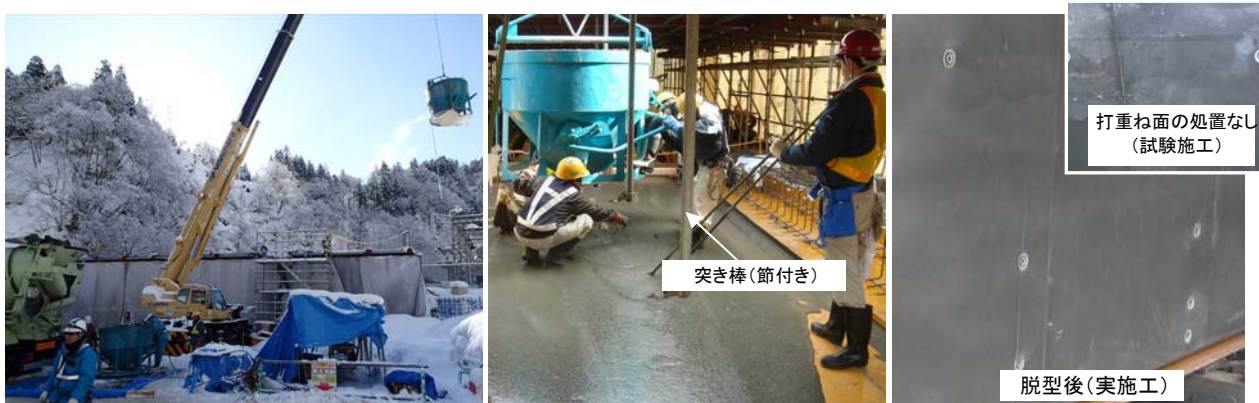
写真-2 打込み・脱型状況
