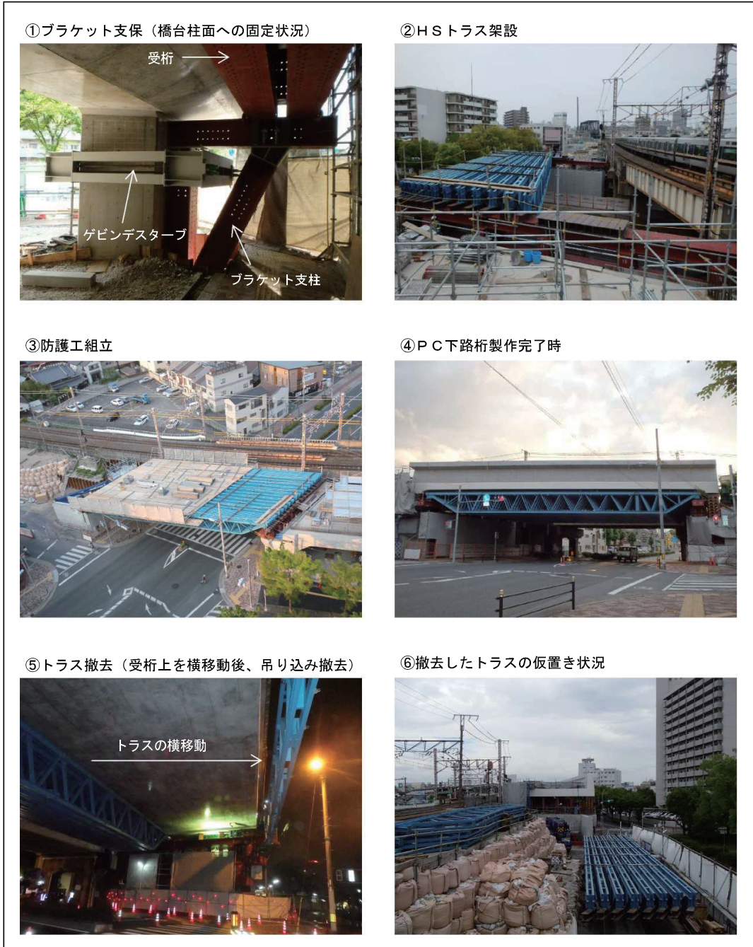
写真-2 架設支保工施工状況
