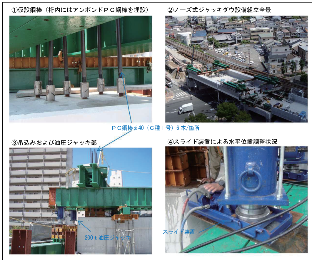
写真-3 ノーズ式ジャッキダウン施工状況
