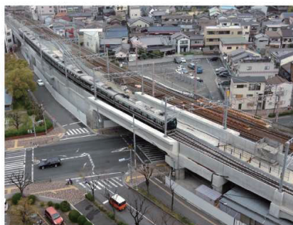
写真-4 完成写真
