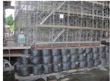
写真-5 調整池部支保工基礎
