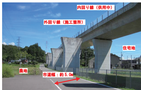
写真-1 現場状況
