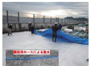
写真-6 上床版部の養生の工夫
