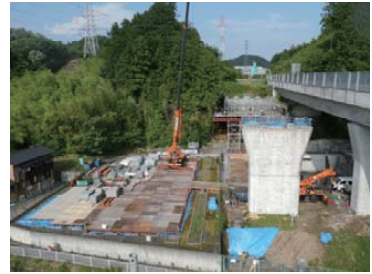
写真-4 施工ヤード
