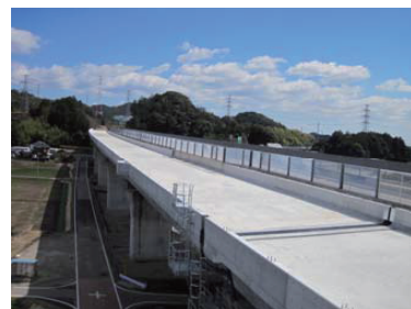
写真-8 完成写真
