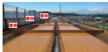
写真-7 型枠組立完了
