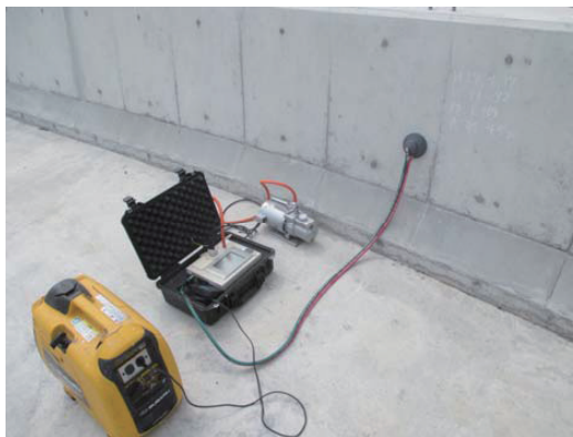
写真-5 透気試験実施状況
