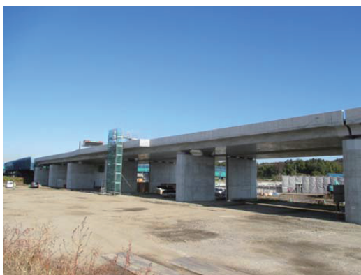
写真-6 多賀城高架橋(南宮地区)完成写真
