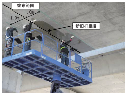
写真-3 表面保護材塗布状況
