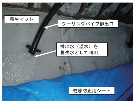
写真-1 橋面養生状況(床版上面)
