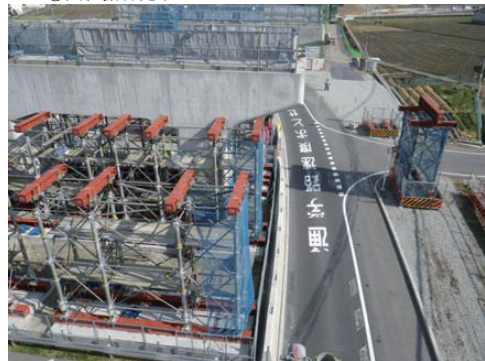
写真-3 ブロック化支柱の施工状況
