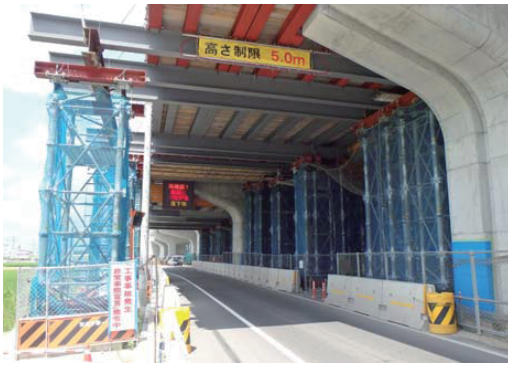
写真-2 支保工設置の現場状況
