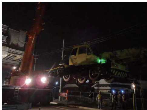
写真-4 クレーン車の橋面設置
