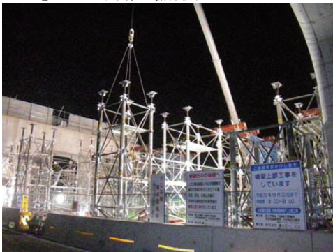
写真-3 ブロック化支柱の施工状況
