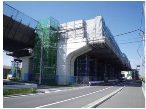
写真-2 支保工設置の現場状況
