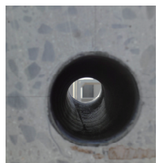
写真-6 確認断面 2-2 における B 社シース
