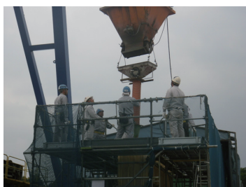
写真-3 縦シュートの建込み
