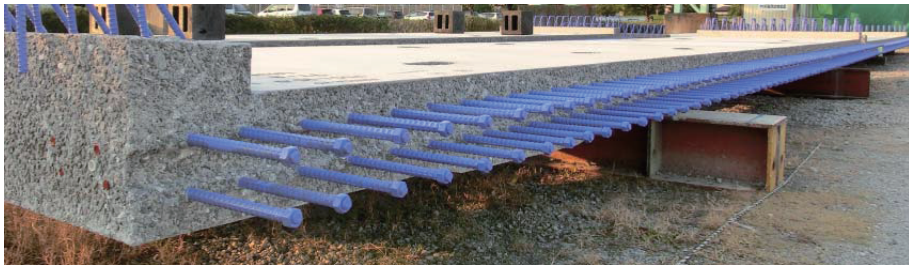
写真－1 合理化継手を採用したプレキャスト PC 床版
