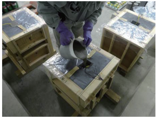
写真-2 間詰部の充填状況
