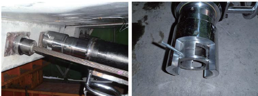
写真-2 ノーズ方式緊張状況
