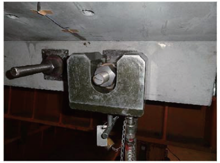
写真-3 ねじ棒圧着方式緊張状況
