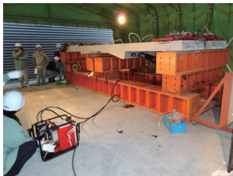
写真-1 緊張試験状況
