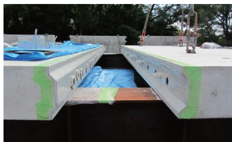
写真-1 床版縦目地構造(接合直前)
