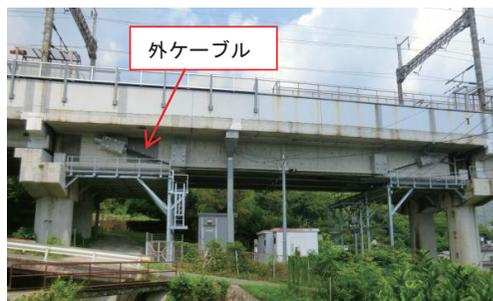
写真-1 外ケーブルの設置状況
