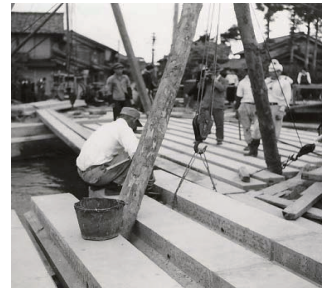
桁架設(吊上げ)
