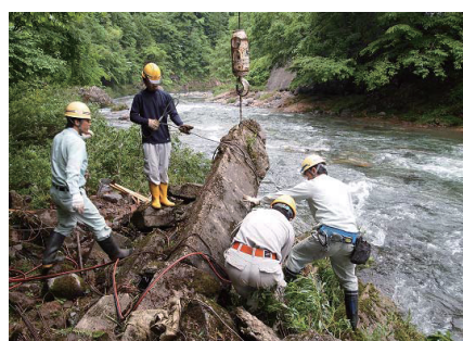
主桁回収状況
