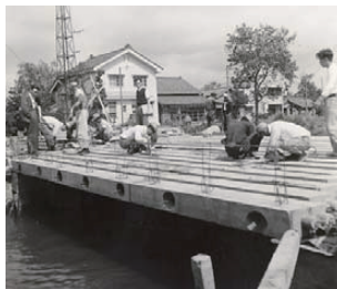
桁間コンクリート打設
