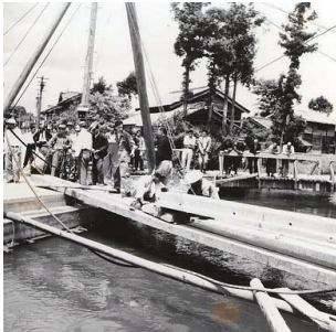
桁架設(引き出し)
