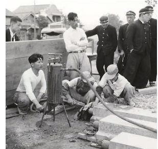
グラウト注入
