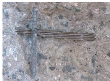
写真-2 内部鋼材状況 (No. 6)
