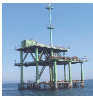
(a) 暴露施設状況
