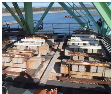
写真-3 暴露試験状況
