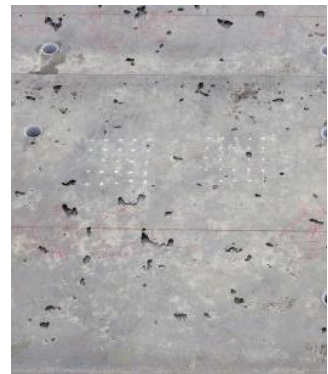
写真-1 表面気泡の状況
