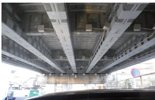
写真-6 施工完了状況
