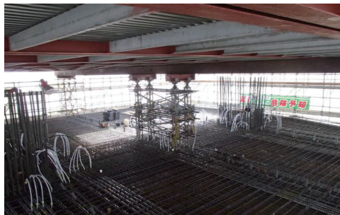
写真-2 養生状況(内部)
