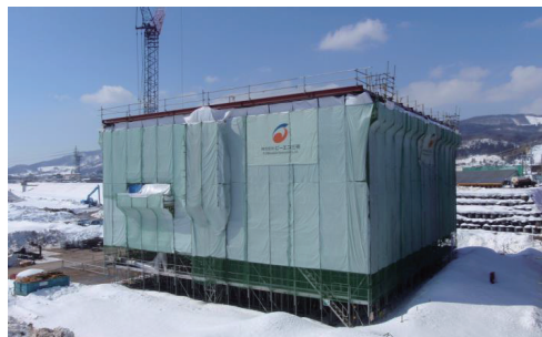
写真-1 養生状況(外観)
