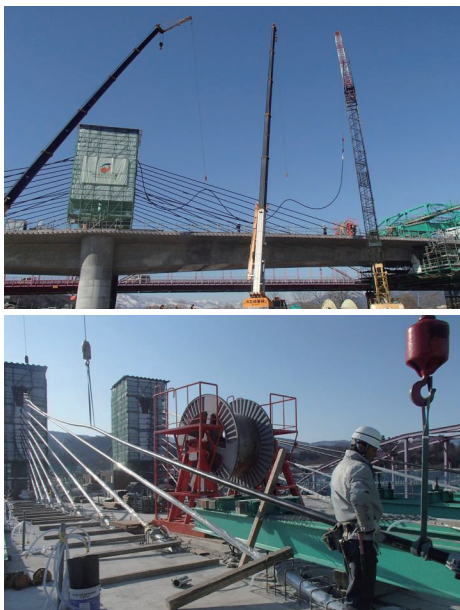
写真-4 斜材架設
