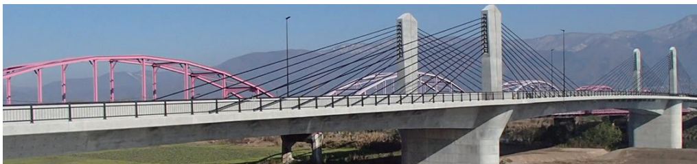
写真-5 完成写真
