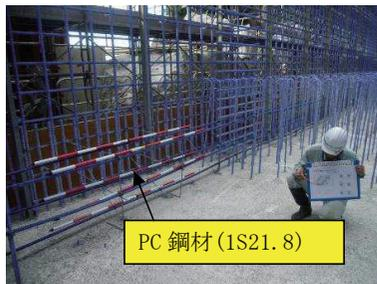
写真-1 PC鋼材配置状況
