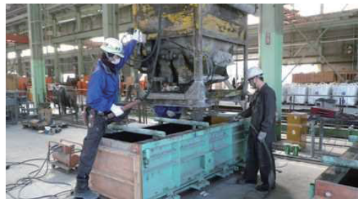
写真-2 コンクリートの打込み状況
