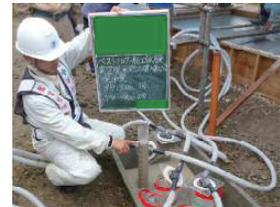
写真-3 脱水量測定状況
