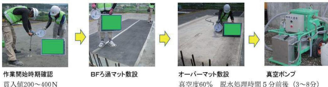
図-1 BF工法の施工管理方法
