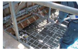
写真-1 PC箱桁断面の下床版ハンチ部
