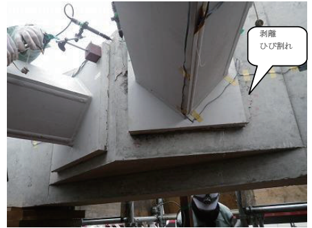
写真-3 載荷試験後試験体状況
