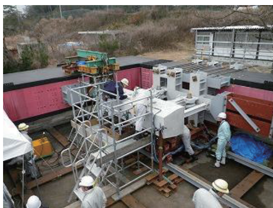
写真-2 試験体載荷状況
