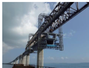
写真-1 張出架設
