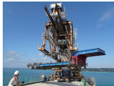
写真-8 トレーラー台車の転回状況
