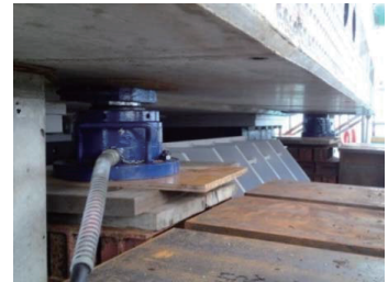
写真-3 スライディングプレート付き油圧ジャッキ
