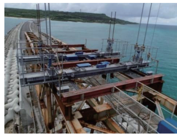
写真-5 A2 側径間部の仮吊装置
