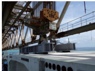
写真-6 セグメント吊装置
