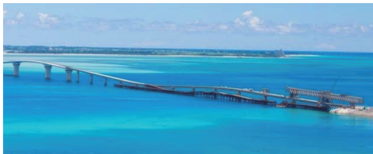
写真-9 伊良部大橋全景(平成26年9月時点)
