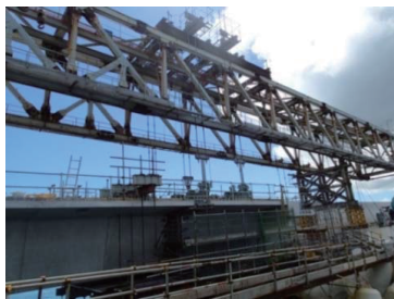
写真-4 A2 側径間部の施工状況
