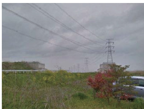
写真-1 高圧送電線の状況
