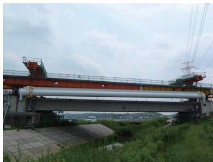
写真-5 水管橋の据付け
