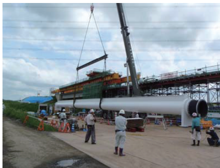
写真-3 水管橋の荷揚げ
