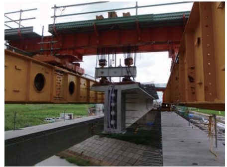
写真-2 架設状況
