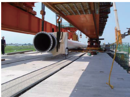
写真-4 水管橋の引出し
