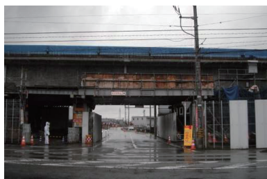
写真-6 支柱式支保工部状況
