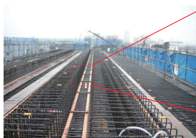
写真-4 上フランジ部型枠設置状況
