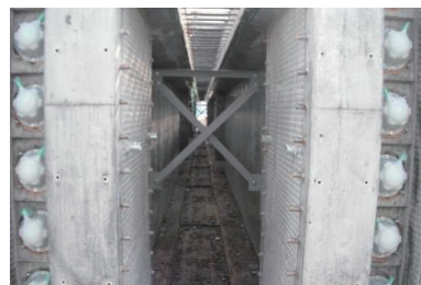
写真-5 端支点部機械式継手配置状況
