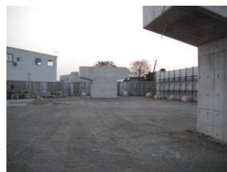
写真-8 地盤改良後整地状況
