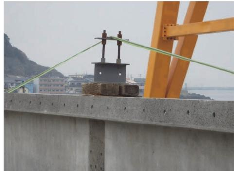
写真-3 仮設ケーブル配置状況
