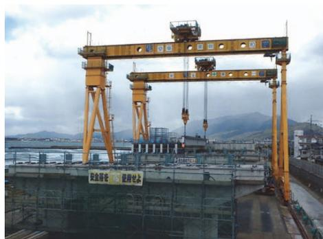
写真-2 自走式門型クレーン架設状況
