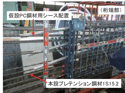
写真-1 仮設 PC 鋼材用シース配置
