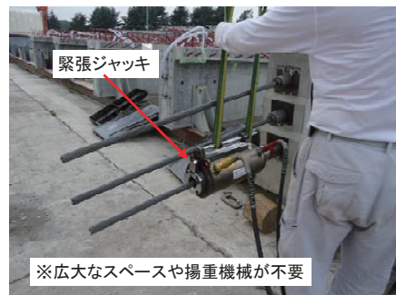
写真-3 仮設 PC 鋼材 緊張状況
