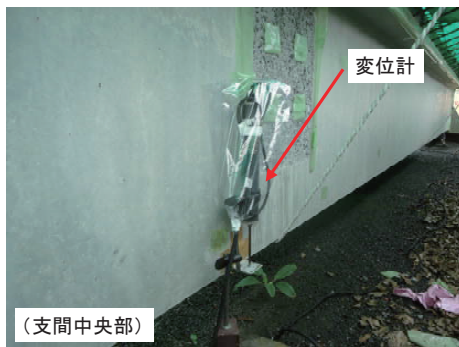
写真-5 変位計設置状況
