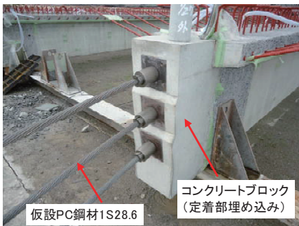
写真-2 仮設 PC 定着ブロック
