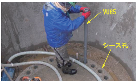
写真-5 シース孔の導通検査状況
