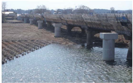
写真-1 完了全景
