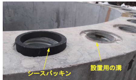
写真-4 シースパッキンの設置状況
