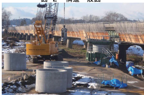
写真-2 施工状況
