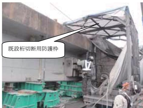
写真-7 既設桁切断用防護枠
