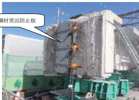
写真-6 PC 鋼材突出防止工(主ケーブル桁端)
