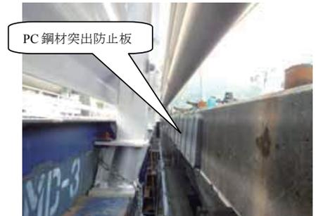
写真-4 PC鋼材突出防止工(横締め)
