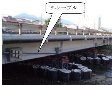
写真-2 外ケーブル補強された和瀬川橋(旧橋)
