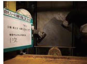
写真-7 樹脂モルタル打設 (1次打設)
