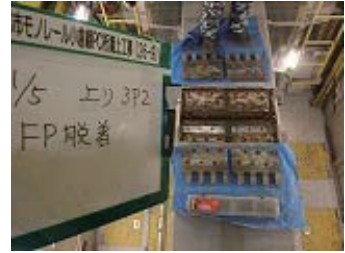
写真-3 事前作業状況
