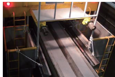
写真-11 落下防止ラック装着状況
