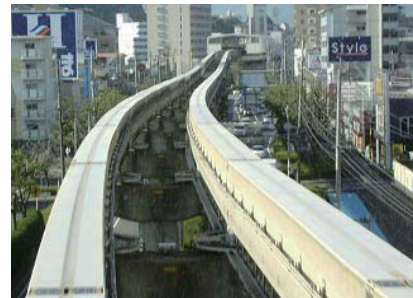
写真-1 着工前の全景
