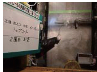
写真-9 トップコート塗布状況(グレー)
