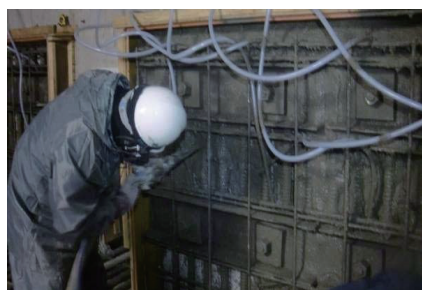
写真-6 吹付け状況
