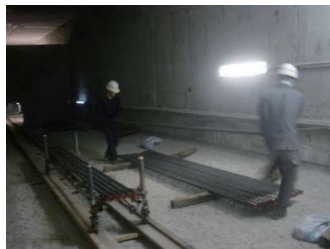
写真-2 鉄筋運搬(桁内)
