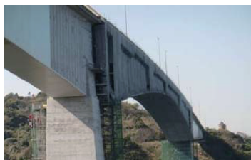
写真-5 吊り足場全景
