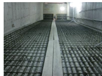
写真-3 鉄筋組立完了
