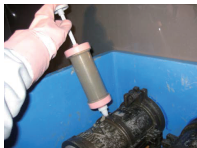
図-3 モルタル注入状況
