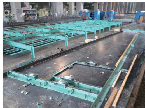
写真-3 扇型段差付スラブ(下段板)型枠
