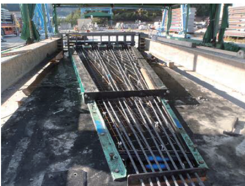
写真-2 扇型段差付スラブ(上段板)型枠
