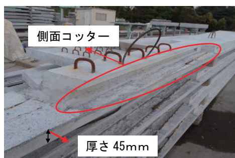
写真-6 段差無し扇型床版(側面コッター部)
