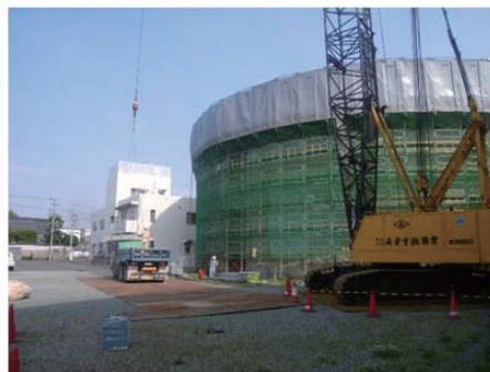
写真-3 ブロック吊り出し
