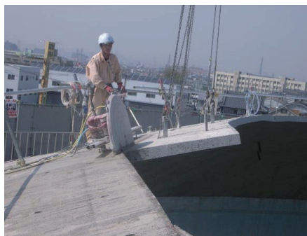
写真-2 ウォールソー工法
