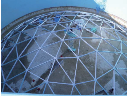
写真-6 アルミドーム組立状況
