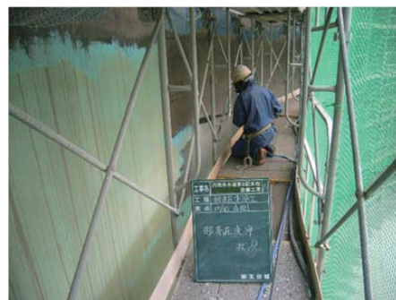
写真-5 超高压洗浄状況
