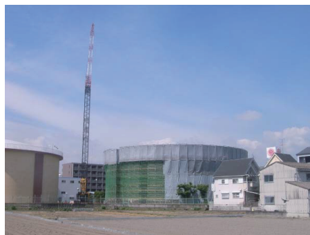
写真-4 防音シート設置状況
