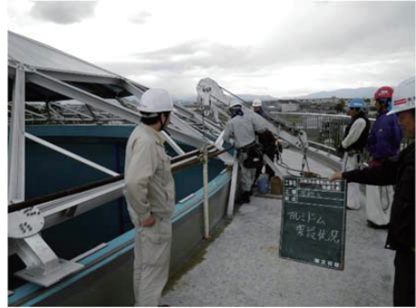
写真-7 アルミドーム架設状況
