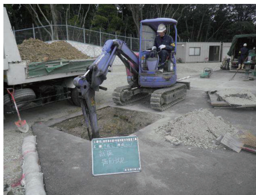
写真-1 試験掘り状況
