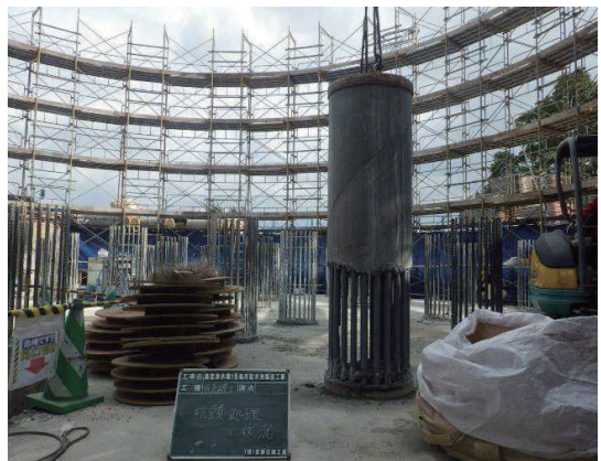
写真-3 杭頭カットオフ状況
