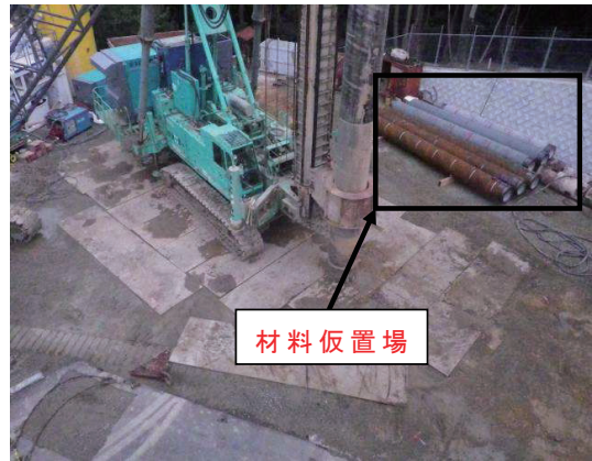
写真-2 基礎工全景
