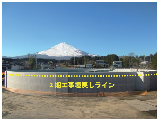
写真-2 タンク全景
