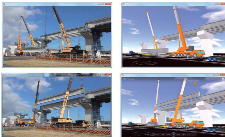
実橋での架設状況
