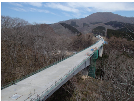
写真-3 橋体完成全景
