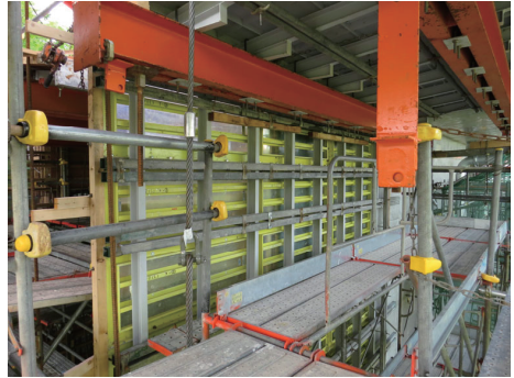
写真-1 透明型枠設置状況
