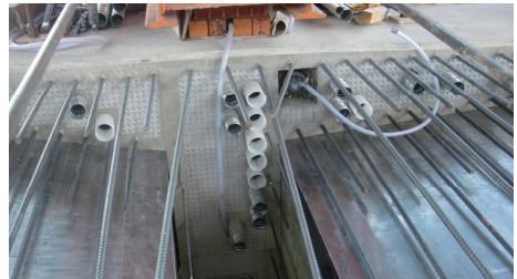
写真-2 シース設置状況
