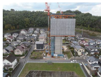
写真-1 民家の隣接状況
