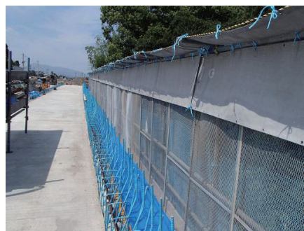
写真-5 橋面防護
