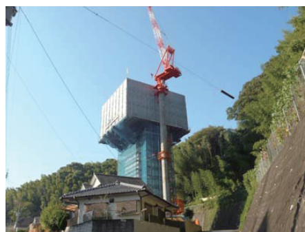
写真-3 防音シート・タワークレーン(P1)
