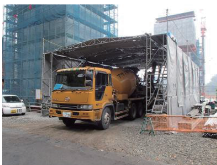
写真-2 防音ゲージの設置
