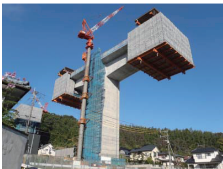
写真-4 防音シート・タワークレーン(P2)
