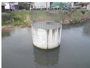
写真-2 P1橋脚
