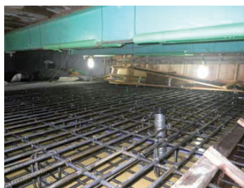
写真-5 型枠組立て完了(箱桁内)
