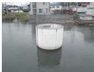
写真-3 P2橋脚
