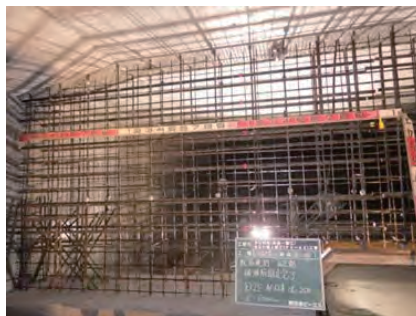
写真-1 鉄筋組立完了
