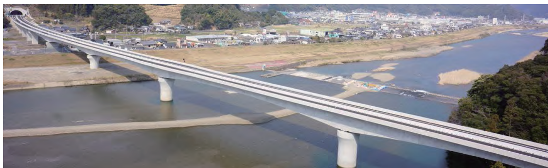
写真-2 完成写真
