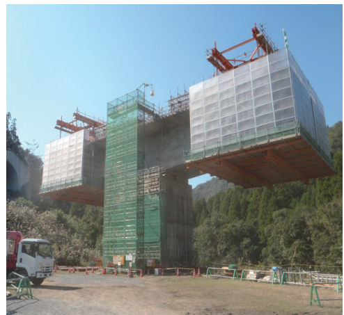
写真-5 透明樹脂板設置状況 (移動作業車外周足場)
