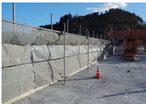
写真-6 忍び返し付き落下物防止柵設置状況
