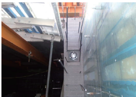
写真-8 樹脂シートを用いた鉛直打継目
