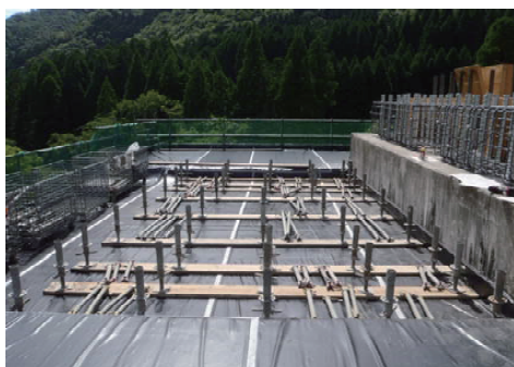
写真-7 防水シート敷設状況
