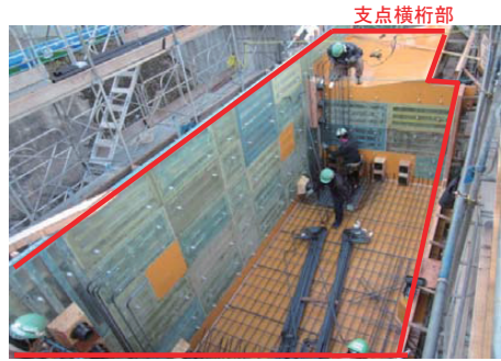
写真-2 支点横桁部の先行施工 (STEP1)
