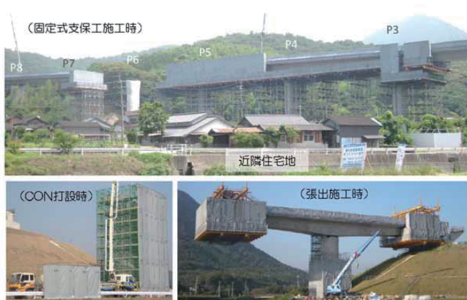
写真-6 防音シートによる騒音対策
