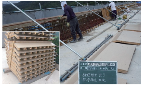
写真-3 リサイクル型枠 (外部にて製作)
