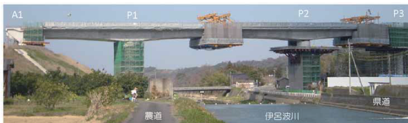
写真-1 施工状況
