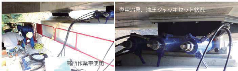
写真-4 ポストスライド工 施工状況
