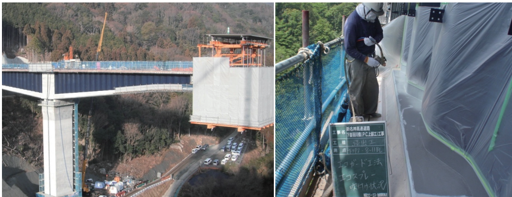
写真-2 防水工施工状況写真
