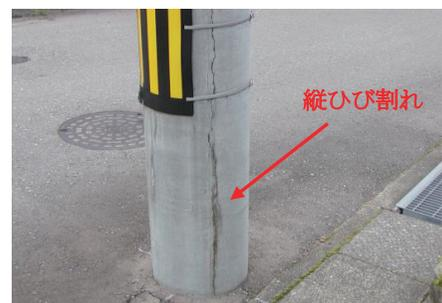
写真-2 PC電柱の縦ひび割れの例
