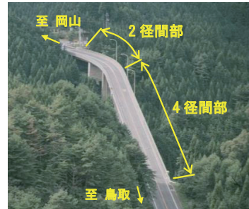
写真-1 那岐大橋全景
