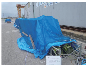
写真-1 ミスト養生状況
