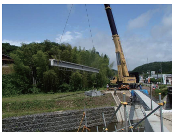
写真-2 架設状況
