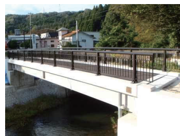
写真-3 完成した宮坂橋歩道橋
