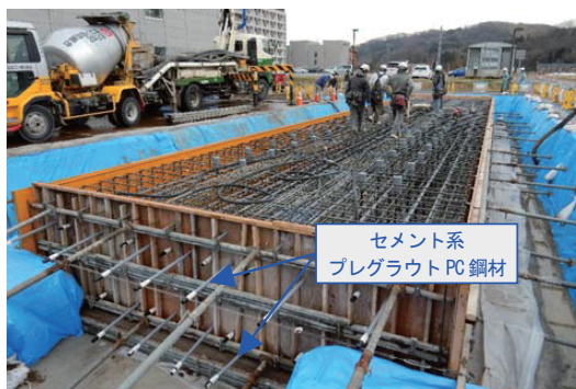
写真-1 載荷台(コンクリート打設前)
