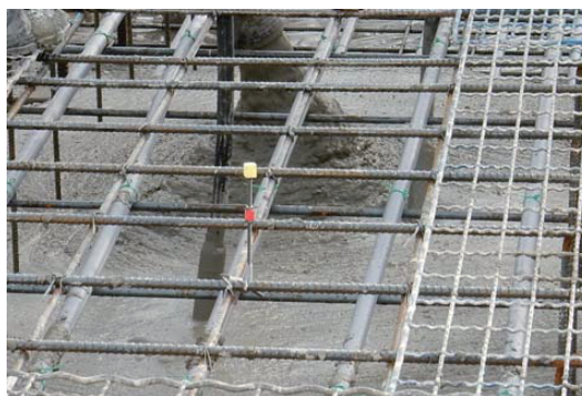
写真-2 コンクリートの打設状況
