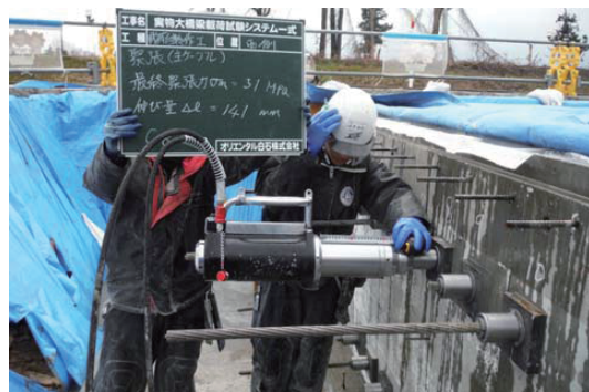
写真-4 セメント系プレグラウト鋼材の緊張
